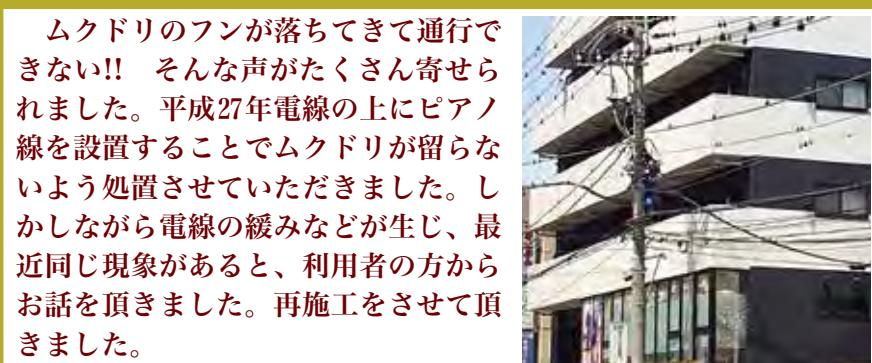
ムクドリの糞が落ちてきて通行できぬ!! そんな声がたくさん寄せられました。平成27年電線の上にピアノ線を設置することでムクドリが留らないよう処置させていただきました。しかしながら電線の緩みなどが生じ、最近同じ現象があると、利用者の方からお話を頂きました。再施工をさせて頂きました。
